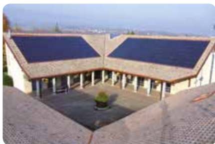
Administration communale, Duillier (automne 2011)
