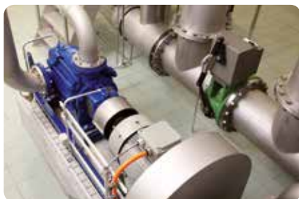
Turbine – Réservoir de Château-Grillet
