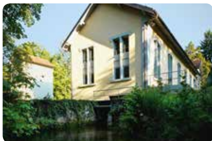
L'usine des Avouillons
