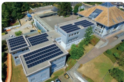
Collège de La Combe, Prangins [automne 2015]
